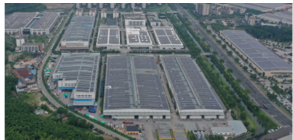
公司厂区敷设光伏发电
